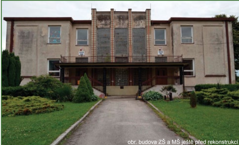
obr. budova ZŠ a MŠ ještě před rekonstrukcí
